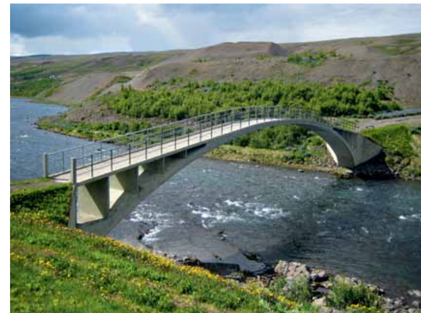
Brücke über den Fnjóská-Fluß, Nordisland, Christiani & Nielsen Engineers, 1908
